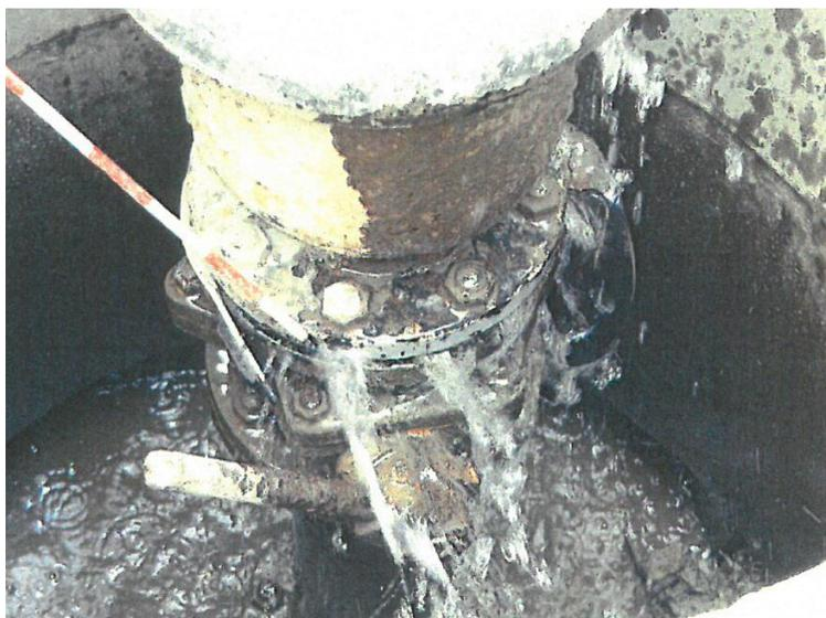
写真-2.3 フランジ継手部からの漏水<sup>4)</sup>
