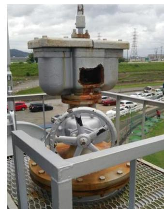
図-1.3 空気弁の破損<sup>11)</sup>
