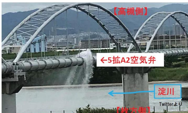
図-1.2 水管橋上の空気弁からの漏水<sup>11)</sup>
