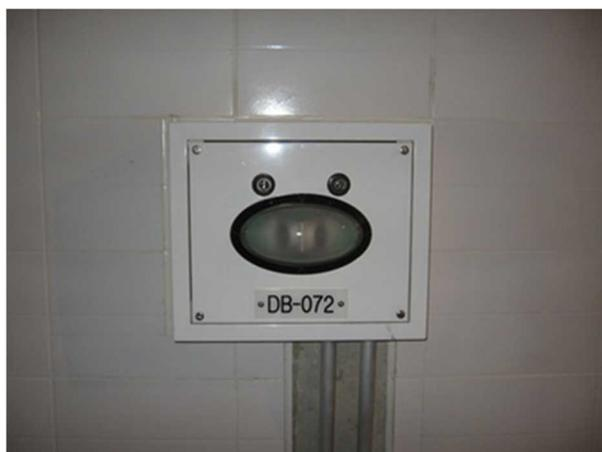
図2-7 炎検出型の火災検知器の外観
