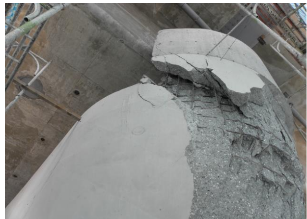
図-9 七星潭大橋 P1 橋脚損傷状況
