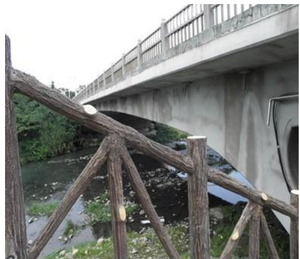
図-18 中正橋桁形状
