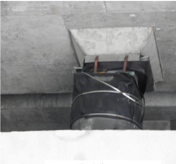
図-11 支承損傷状況
