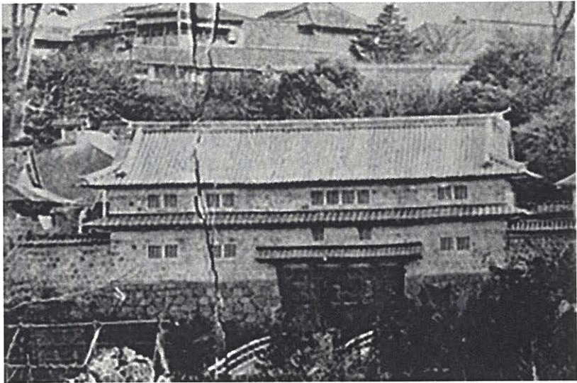
図4. 金沢城・鼠多門の写真、 明治初年の鼠多門および鼠多門橋の写真、金沢城門等 写真、金沢市玉川図書館蔵。 左奥に見える建物がスロイス御貸家の屋根と推定される。
