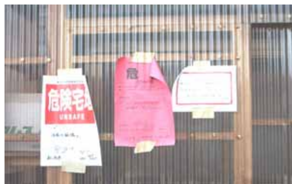
写真-1 判定結果ステッカー表示（小千谷市） （左側：被災宅地危険度判定、中央：被災建物危険度判定、右側：小千谷市のお知らせ）
