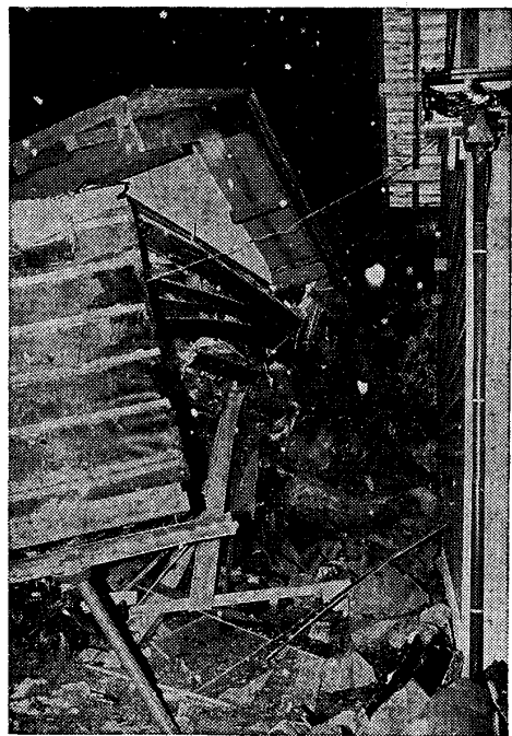
写真四 裏山の崩落による住家の損壊 (正院町岡田)
