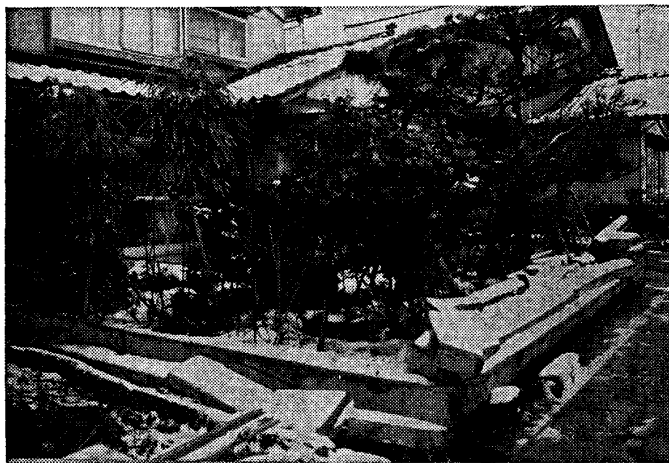
写真三 石積塀の転倒 (正院町正院)
