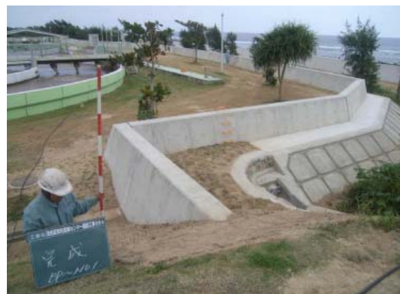
写真-2 被災後の堤防の嵩上げ (知名環境センター提供)
