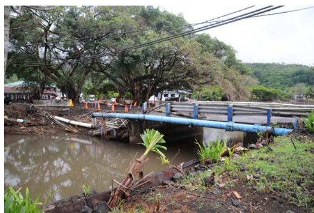
写真-6 Leone における橋梁添架管の仮復旧状況
