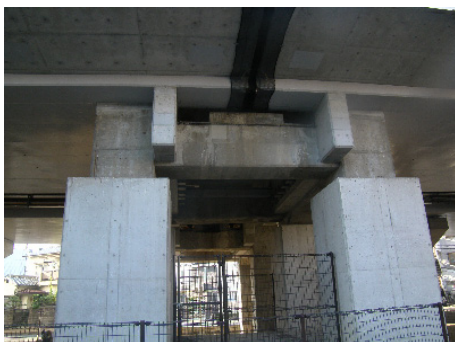
写真-1 立体ラーメン A5 橋台 (ラーメン化後)
