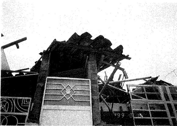
写真3 無補強の煉瓦造の被害例（無補強の煉瓦壁の頂部には臥梁のような部材が無く、単に屋根が壁の上に乗っている。煉瓦は通常の焼成煉瓦が多いが、穴開き煉瓦も用いられている。アルメニア市内）
