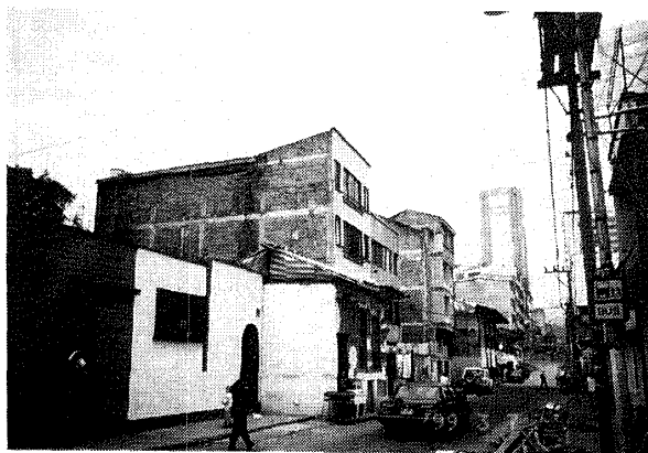
写真2 鉄筋コンクリート造のラーメン構造は2階までで、3階の途中で柱がなくなっている例（それでも柱梁が全く無い無補強の煉瓦造と比較すると良い構造である。ペレイラ市内）
