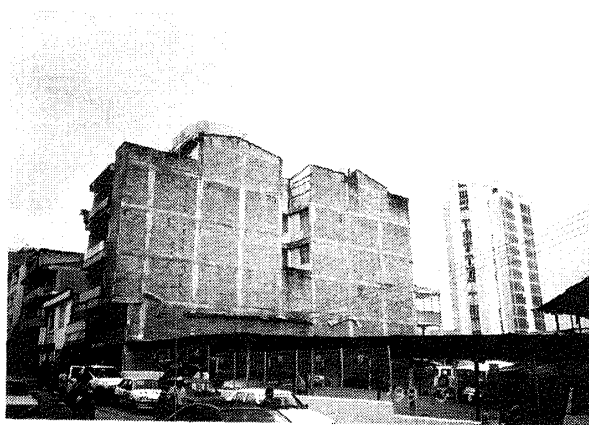
写真1 鉄筋コンクリート造のラーメンに煉瓦壁がはめ込まれている典型的な構造（煉瓦壁は全く無補強であるがラーメンで囲まれており耐震的に比較的良い構造である。ペレイラ市内）
