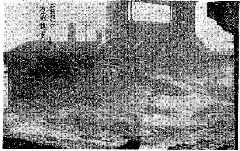
写真3 愛本堰堤上流左岸より望む(7月1日, 10時)
