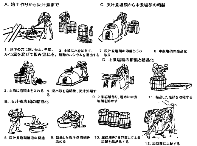
図11. 培養法による塩硝の生産 ([塩硝のふるさと平村]平村郷土館, 1991)
