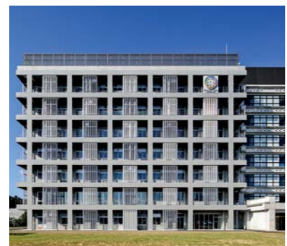
バイオマス・グリーンイノベーションセンターの外観。
