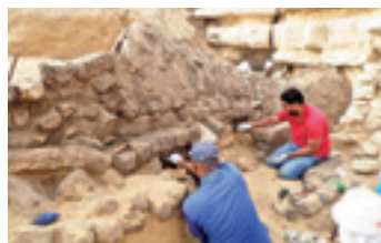
カタコンベ入口前の通廊を覆う日干レンガ製のヴォールト天井の壁の修復作業
