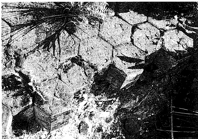
写真52. 尾小屋集落各所にみる「亀の甲カラミ煉瓦」 (筆者1996. 7)
