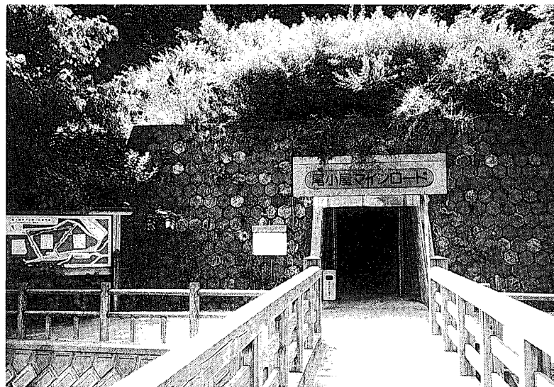
写真49. 鉱山資料館横の尾小屋メインロード入口と両壁の カラミ煉瓦 (筆者1996. 7)
