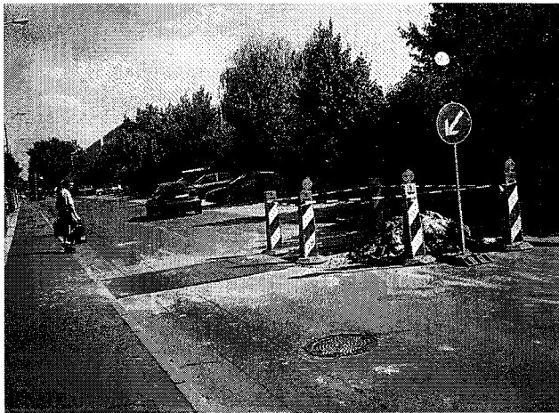
「素朴な」工事現場（ポツダム）
