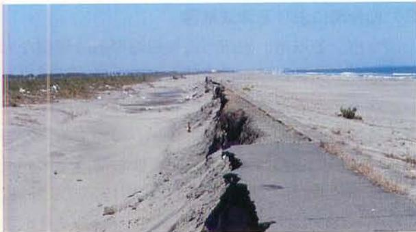
図4 仙台空港東側の海岸堤防の被害。
