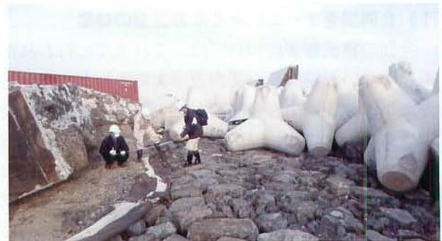
図7 高砂埠頭コンテナターミナル南東側の護岸の被害。
