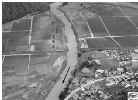
a) 第4鉄橋下流上空より（国際航業株式会社）
