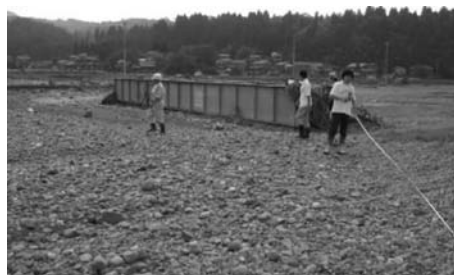
(b) 堤内地に侵入した橋桁（河道寄りから、著者撮影）
