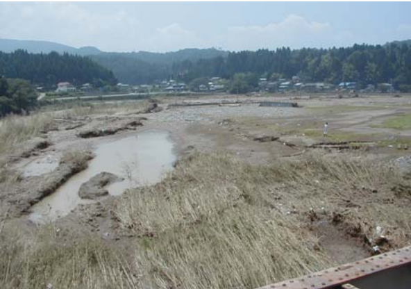
(d) 下流右岸の高水敷の侵食と破堤の状況 (著者撮影)
