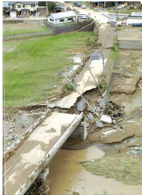
図-5 高田大橋周辺被害状況 （2004年7月19日福井新聞社撮影）
