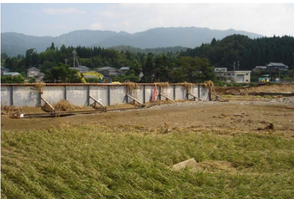
(c) 堤内地に侵入した橋桁 (堤内地寄りから, 著者撮影)
