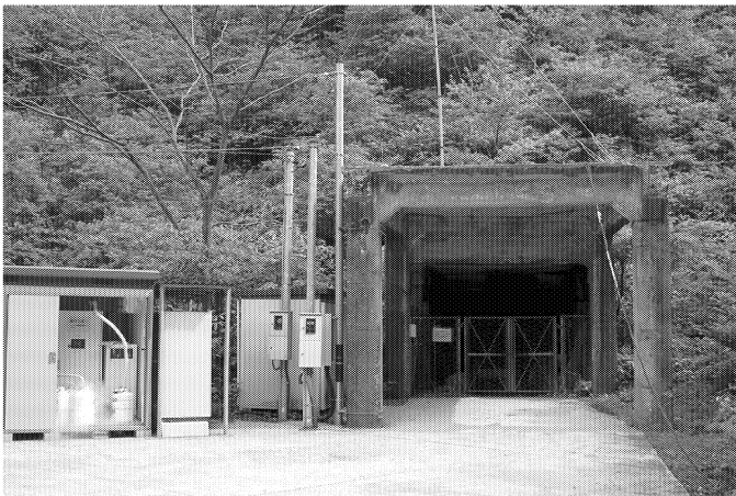
尾小屋トンネル入り口
