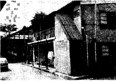
農家の庭先に設けられたアパート(戸板地区)
