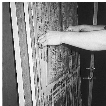
写真13 仮張りに張る
