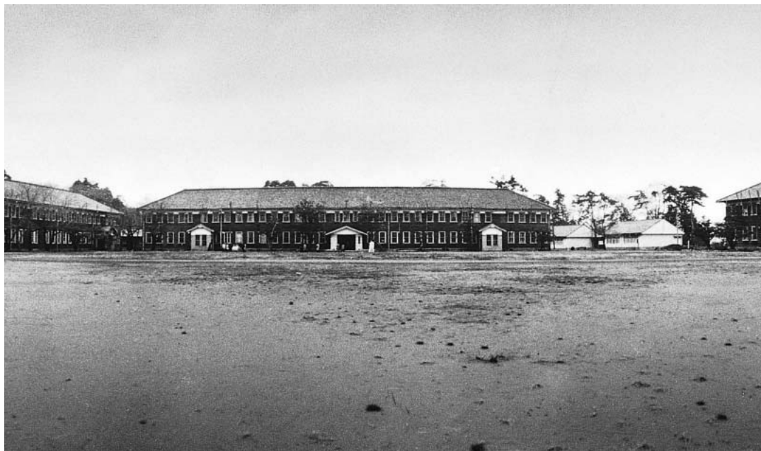
写真1 - 1 法文学部時代の校舎。城内キャンパス大手門に近い位置にあった。 左から法文学部（1号館）、同（2号館）、同（3号館）
