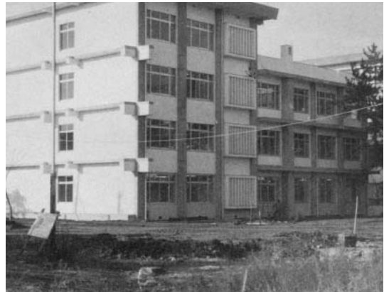
写真3-6 竣工直後の法文学部2号館 (一部3階建てとなっている)
