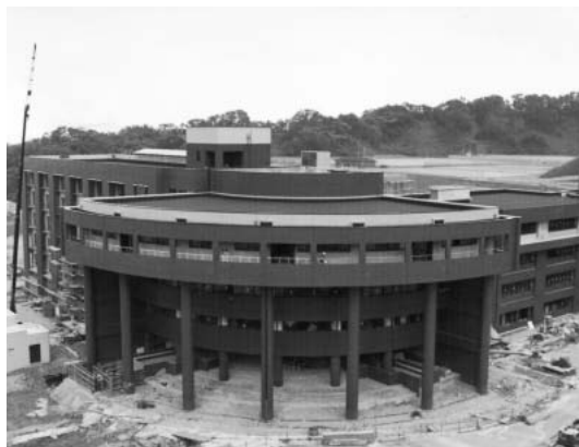
写真5-4 完成間近い教育学部角間キャンパスの新校舎（平成4年5月）
