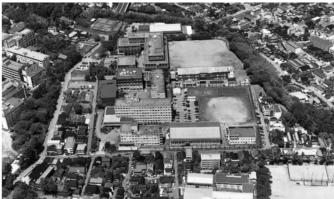
写真 8 - 3 医療技術短期大学部（金沢大学鶴間キャンパス）周辺の遠景（平成9年5月撮影）
