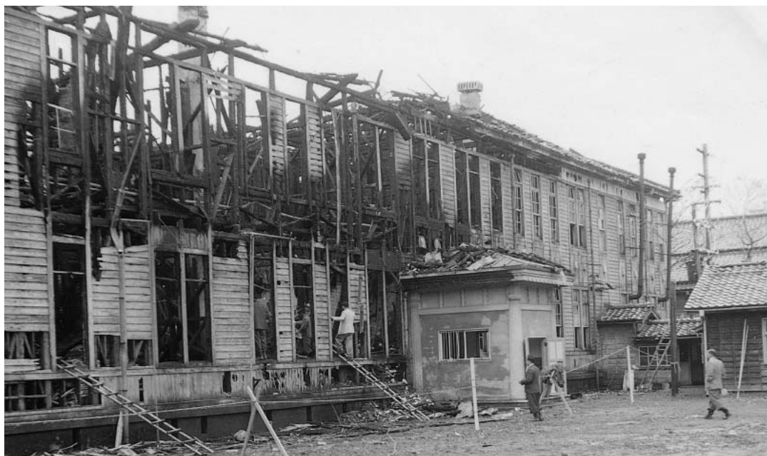
写真9-4 火災後の写真
