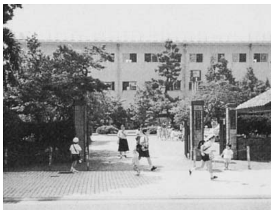
写真14-16 移転前の広坂旧校舎
