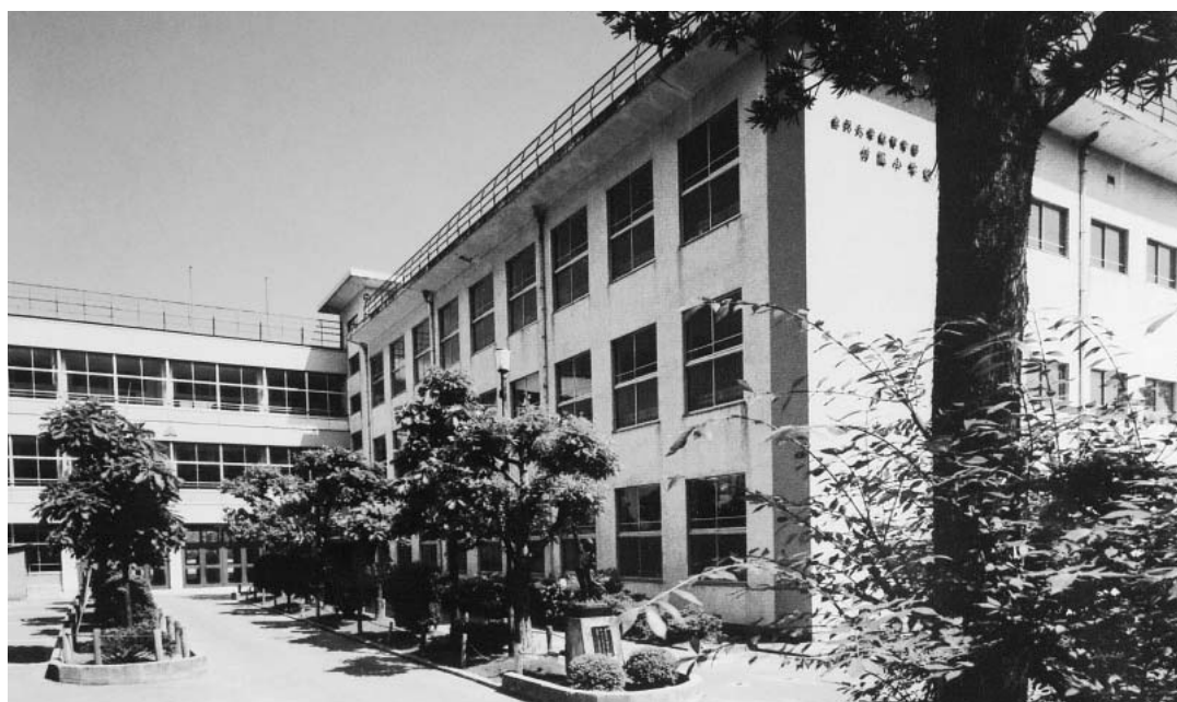
写真 1 4 - 5 旧広坂小学校校舎
