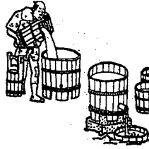
3. 土桶に水を加えて、硝酸カルシウムを浸出する
