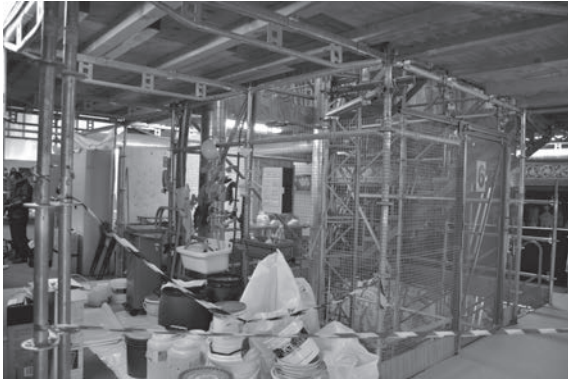
図 17 壁画前に組まれた足場の一部
