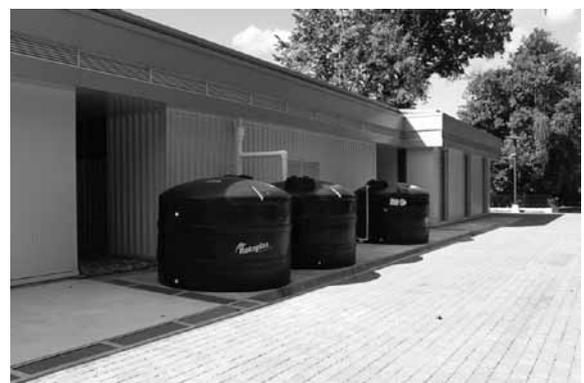
写真4 センター外部の雨水貯水タンク
