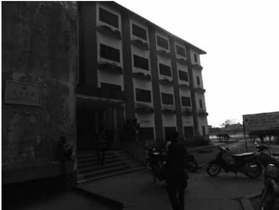
写真 12 アボメカラビ大学孔子学院が入居している建物(筆者撮影)
