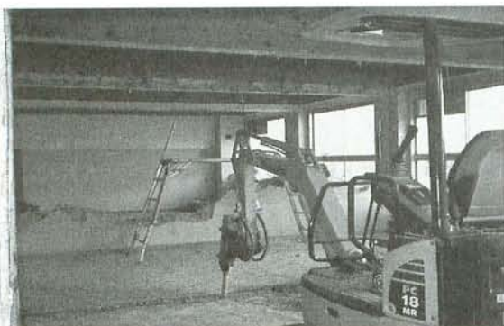
(工事中の平和町校舎)
