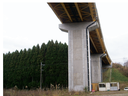
写真-1 PC 鋼材巻立てによる耐震補強
