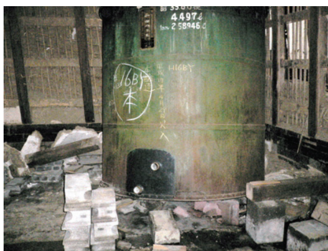
写真 7 コンクリート台から落下して傾いた酒造タンク。背景は土壁が落ちた酒蔵の内壁
