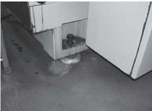
写真5 ずれた工作機械
