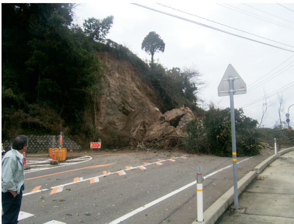
写真 1.5 深谷中浜線 志賀町深谷地内
