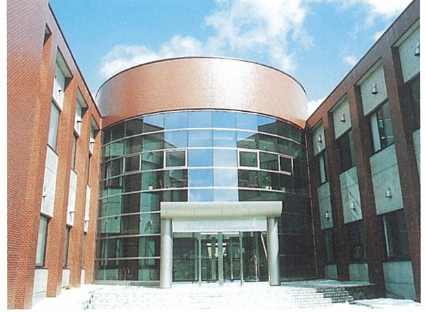
総合情報処理センター General Information Processing Center
