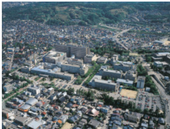
新病棟と建設が進められる中央診療棟▶
