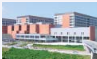
竣工した自然科学棟
