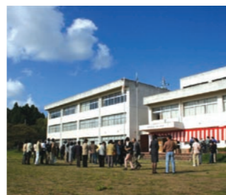
里山里海自然学校の拠点となる旧・小泊小学校校舎
