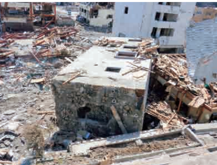
安全と言われていた鉄筋コンクリートの建造物も転倒(宮城県女川町, 3月19日) 写真提供・宮島昌克教授(下の写真も同じ)
