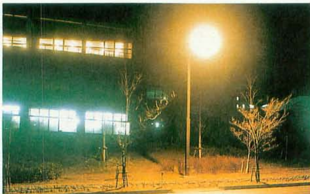
大学会館前T字路交差点に設置されたナトリウム灯
