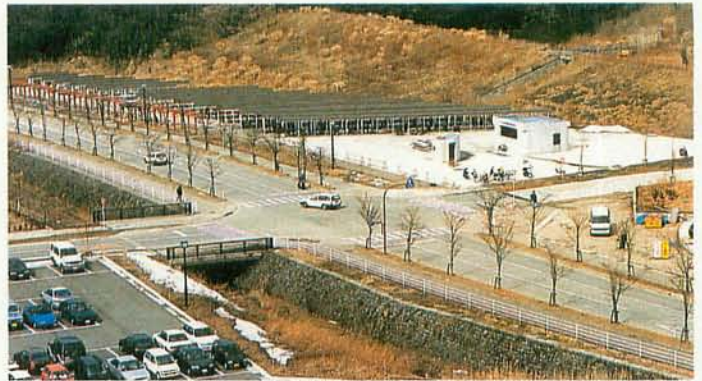
信号機が設置される予定の大学教育開放センター前交差点
