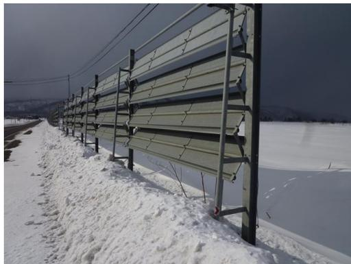
図 6-1-1 北海道地方に設置されている吹き払い式防雪フェンス
