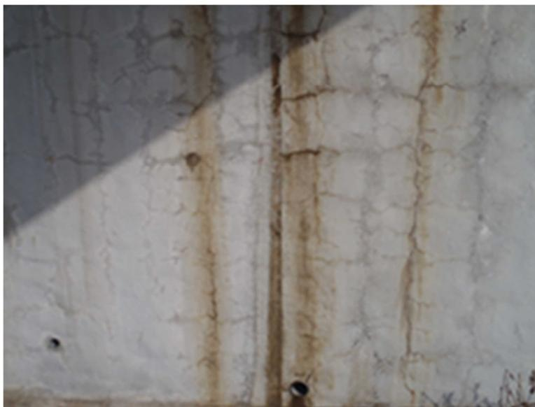
写真-4.4 ひび割れの発生状況
