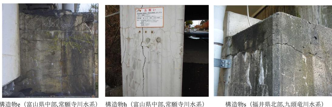
写真-2.1 構造物のASR劣化状況の一例
