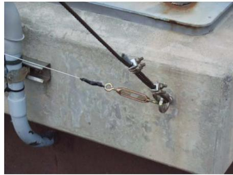
(オ) カメラから機械室内 PC への配線 (カ) ワイヤーで固定される土台部分
