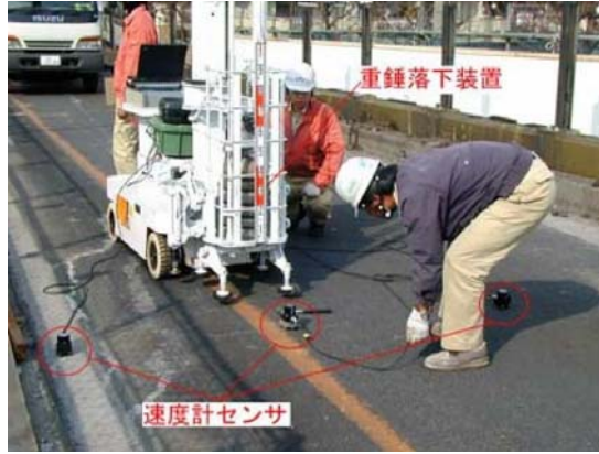
写真-4.3.2 IIS(Impulse Input System Method)による計測状況
