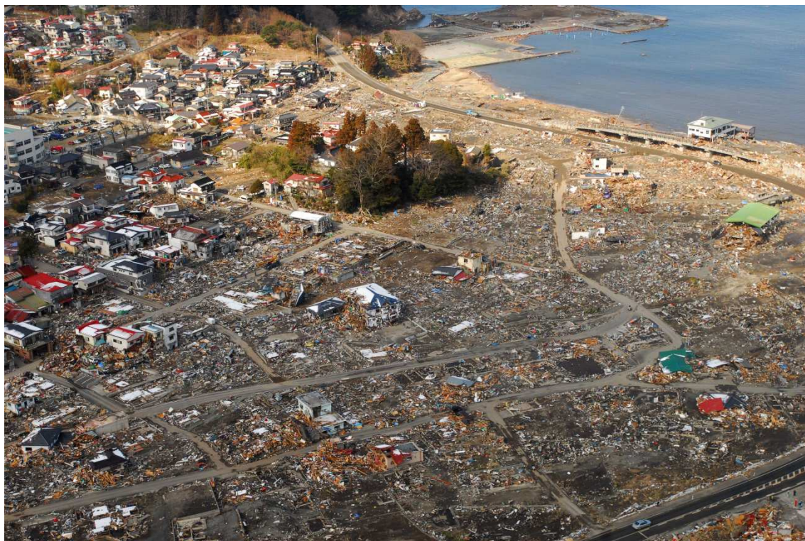
図 1 - 2 被災から 1 週間後の三陸海岸（2011 年 3 月 18 日、岩手県上閉伊郡大槌町・吉里駅周辺（アメリカ合衆国海軍撮影）
