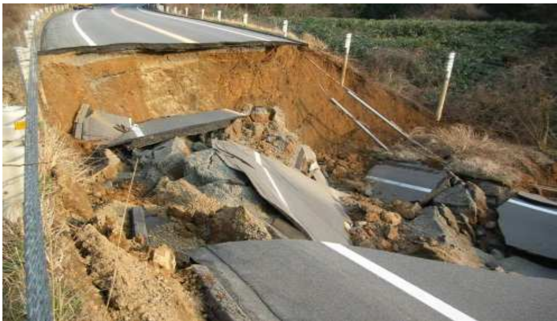
能登有料道路 七尾市中島町谷内
