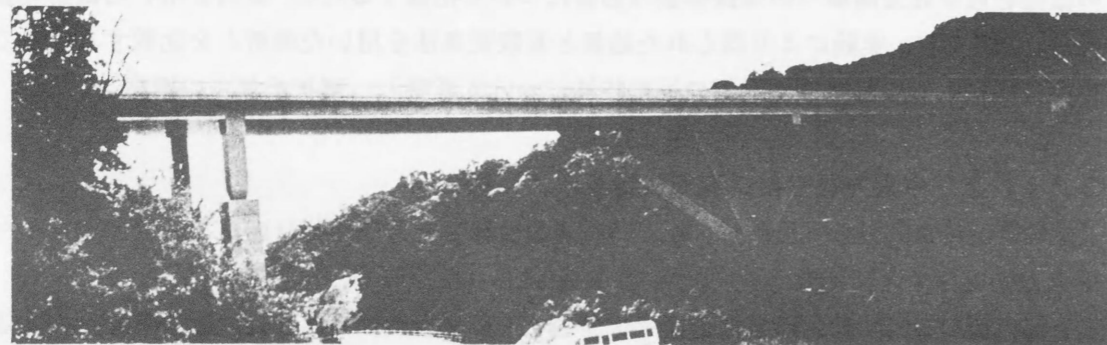
写真— 5.2 中央方杖支持式連続箱桁ラーメン橋
