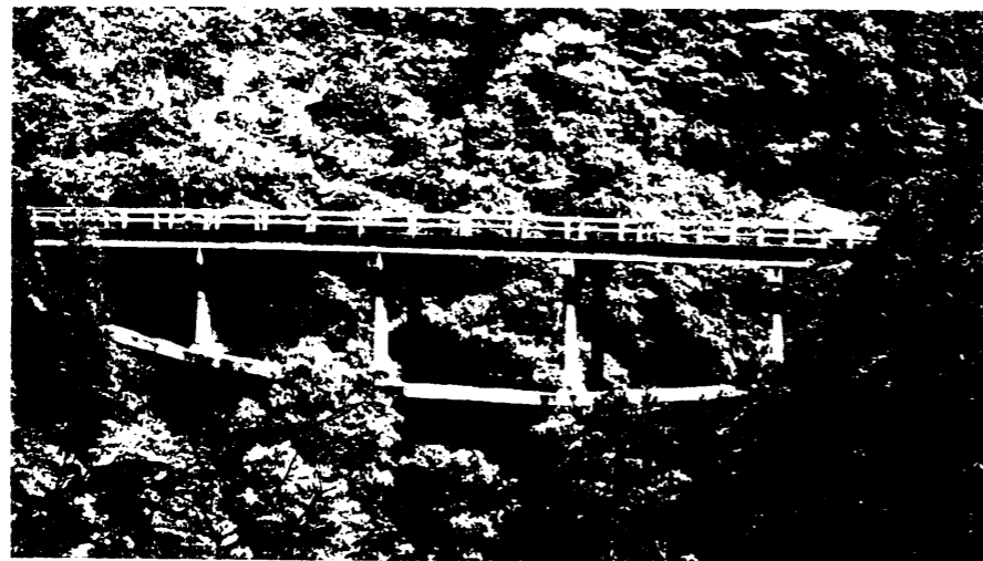
写真-6.1 速日峰橋
