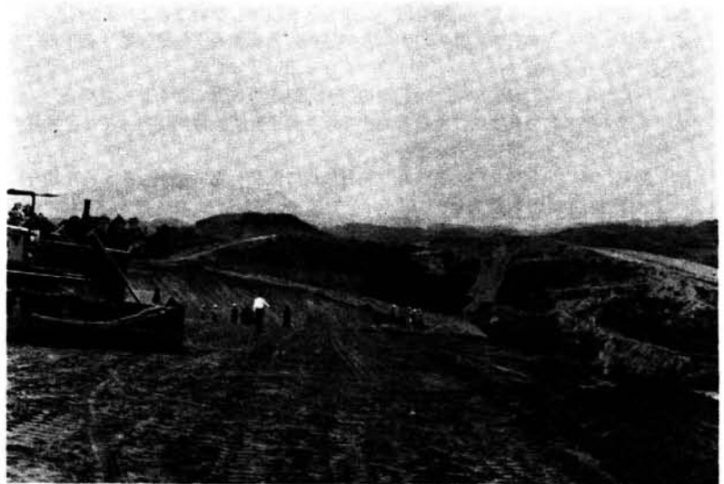
▲夕日寺地区のゴルフ場建設現場
