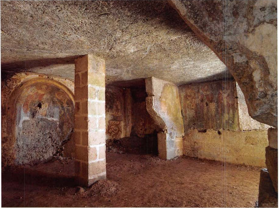
後陣の前には近年の補強とみられる角柱が天井壁を支えている
