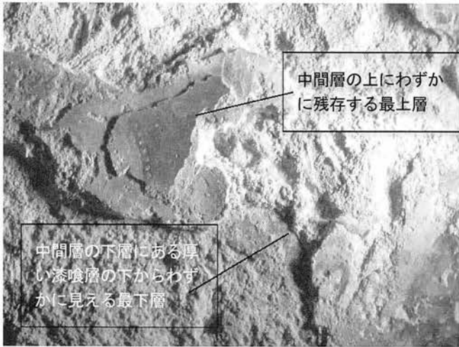
Fig.12 後陣壁の正面左側壁における3層構造
