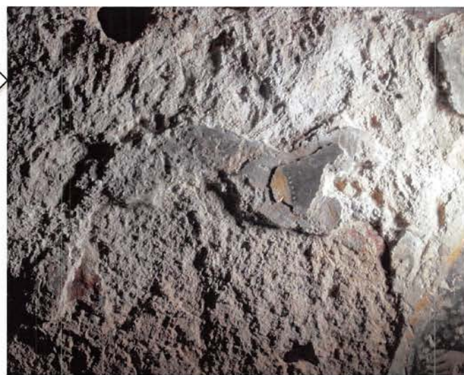
正面左壁面の3層構造部分
